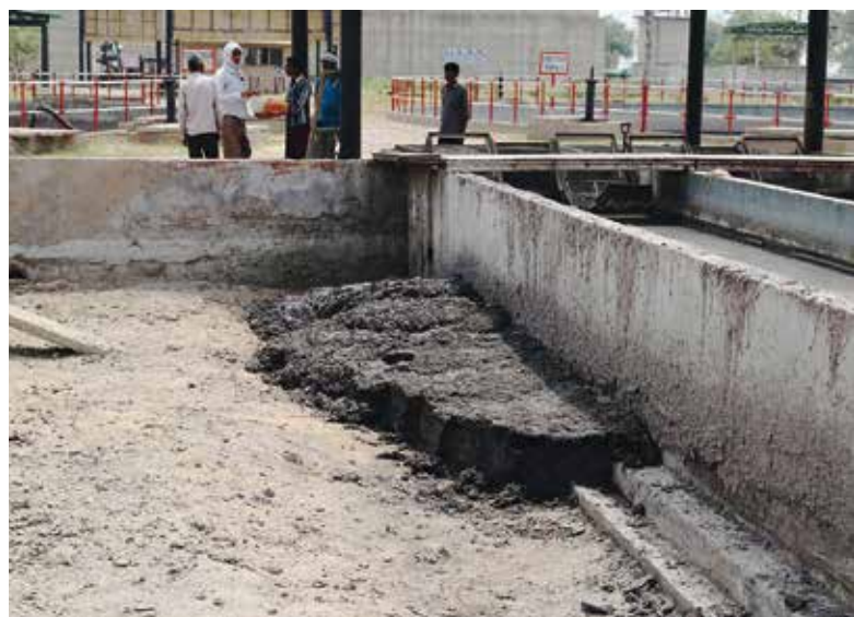
Klärschlamm aus Gerbereiabwässern
