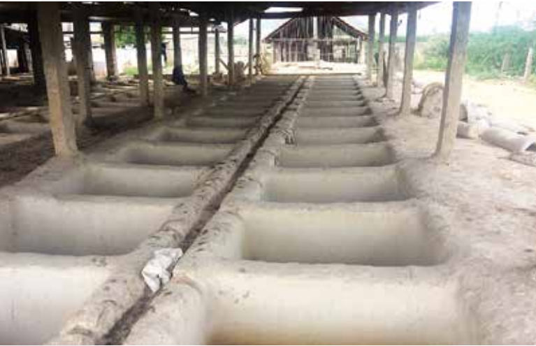
Ansicht der Äschergruben in Gerberei 1, wo die Häute eingeweicht werden
