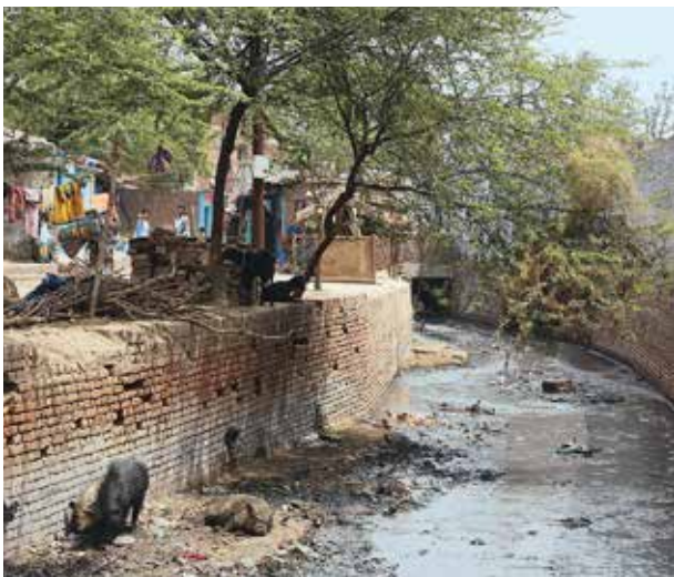
Kommunale Abwässer und Gerbereiabwässer werden durch eine arme Wohngegend in Kanpur geleitet
